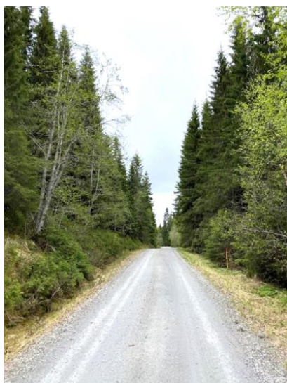
Figur 42 Skogsbilveien fra Bjørset til Berkåk
