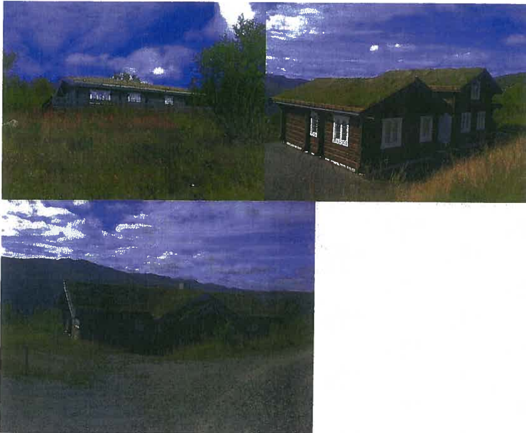
Bildene viser noe av den eksisterende bebyggelsen i hyttefeltet, to av bildene viser noen av de nyere oppsatte hyttene i feltet. Mye av den eldre bebyggelsen i har møneretningen tverrstilt i forhold til terrenget.
